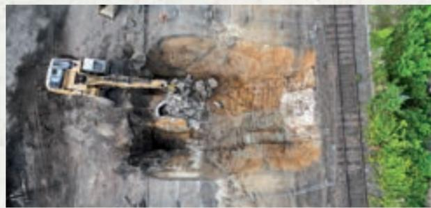
Die Tiefenentwässerung wurde verlegt, der bisherige Durchlass abgebrochen und ein neuer, 20 m langer Durchlass mit einem Schwerlastkran eingehoben.
