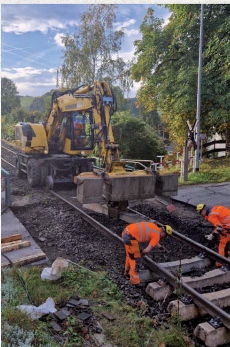
Diese Befestigungsmittel sind nötig, um die Schienen mit den Schwellen zu verbinden – u.a. mit Schraubenmutter, Federringen, Schwellenschrauben und Klemmplatten. Mit einem Zweiwegebagger, der mit einem hydraulischen Anbaumagneten ausgestattet ist, werden diese Materialien aufgelesen und per Knopfdruck auf dem SKL-Gleiskraftwagenanhänger abgelegt.
